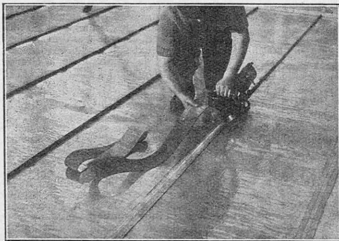
FIG. 2. — MISE EN PLACE D'UN COUVRE-JOINT
