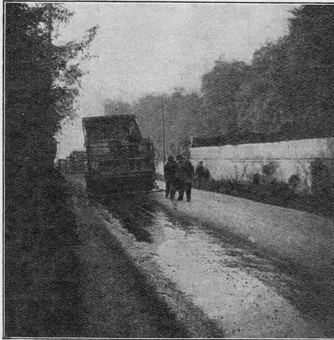
FIG. 2. — LE GRAVILLONAGE AU CAMION PERMET DE TRAITER RAPIDEMENT DES SURFACES ASSEZ ÉTENDUES
