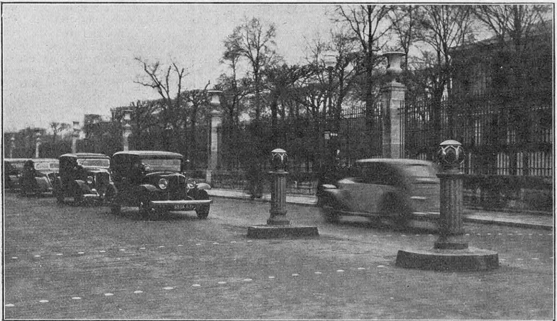
RUE DE RIVOLI A PARIS. — AU PREMIER PLAN : DEUX BORNES LUMINEUSES AU GAZ
