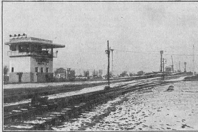
FIG. 1. — VOICI LA « BUTTE » DE TRAPPES-TRIAGE, AVEC LES VOIES DESCENDANTES ET LES PREMIÈRES AIGUILLES. A gauche, la cabine vitrée du chef de butte, surmontée de quatre haut-parleurs. La butte de triage est au fond à droite.
