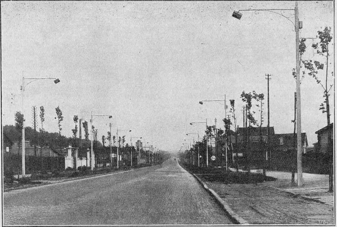
FIG. 3. — LA ROUTE NATIONALE N° 3 A LA SORTIE DE PARIS, ENTRE BOBIGNY ET NOISY-LE-SEC, EST ÉQUIPÉE DE LAMPADAIRES PORTANT DES LAMPES A VAPEUR DE SODIUM
