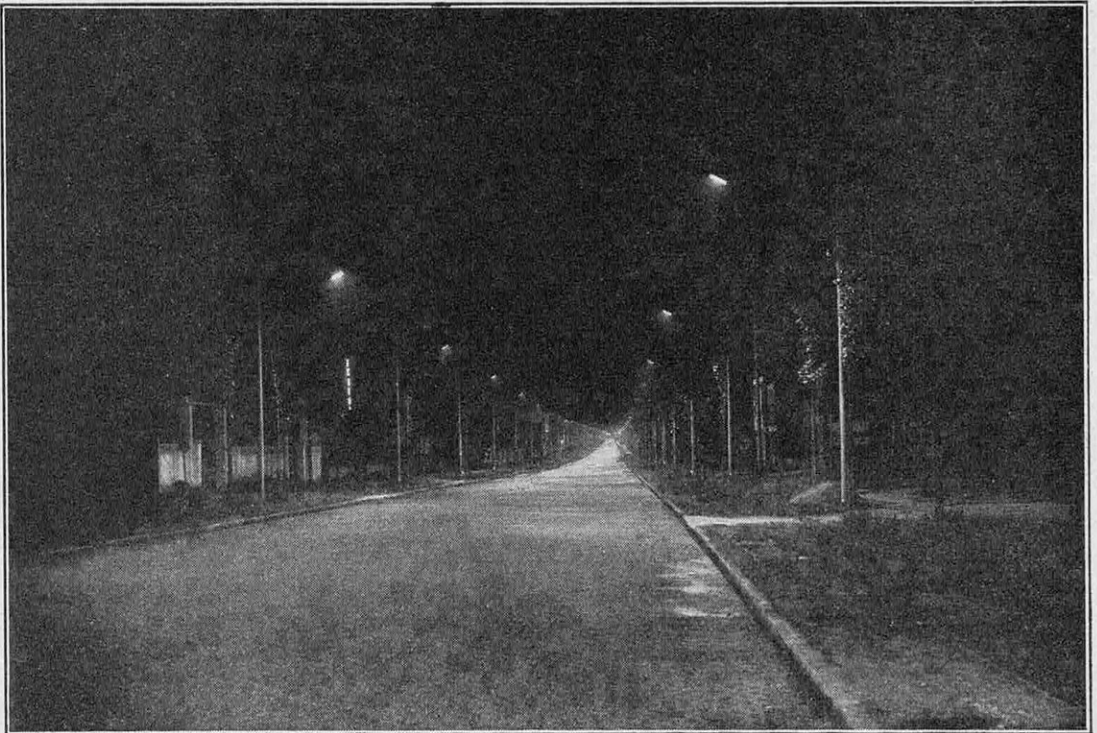
FIG. 4. — VOICI CETTE MÊME ROUTE NATIONALE N° 3 PHOTOGRAPHÉE DE NUIT AVEC LES TUBES A VAPEUR DE SODIUM EN FONCTIONNEMENT PROTÉGÉS PAR DES RÉFLECTEURS
