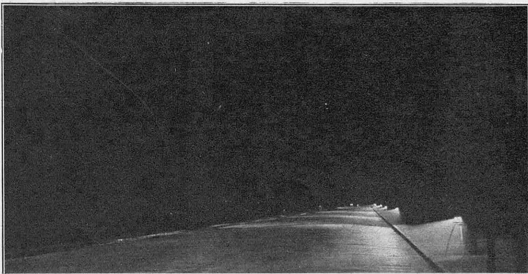
FIG. 6. — PROCÉDÉ TOUT A FAIT MODERNE D'ÉCLAIRAGE ROUTIER PAR « PHOTOSTRADES », BORNES ÉCLAIRANTES QUI PROJETTENT DES FAISCEAUX DE LUMIÈRE RASANTE FAISANT RESSORTIR AU MIEUX LES MOINDRES OBSTACLES, SANS JAMAIS ÉBLOUIR LES CONDUCTEURS
