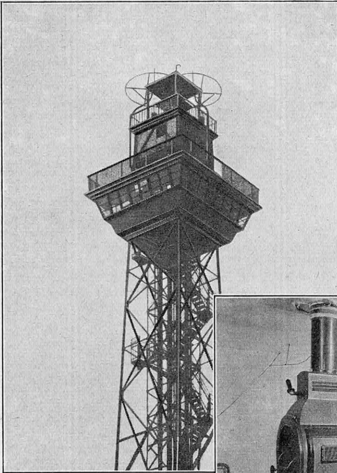
FIG. 1. — SOMMET DE LA TOUR DE BERLIN-WITZLEBEN MONTRANT LES ANTENNES ANNULAIRES POUR L'ÉMISSION DES ONDES COURTES
