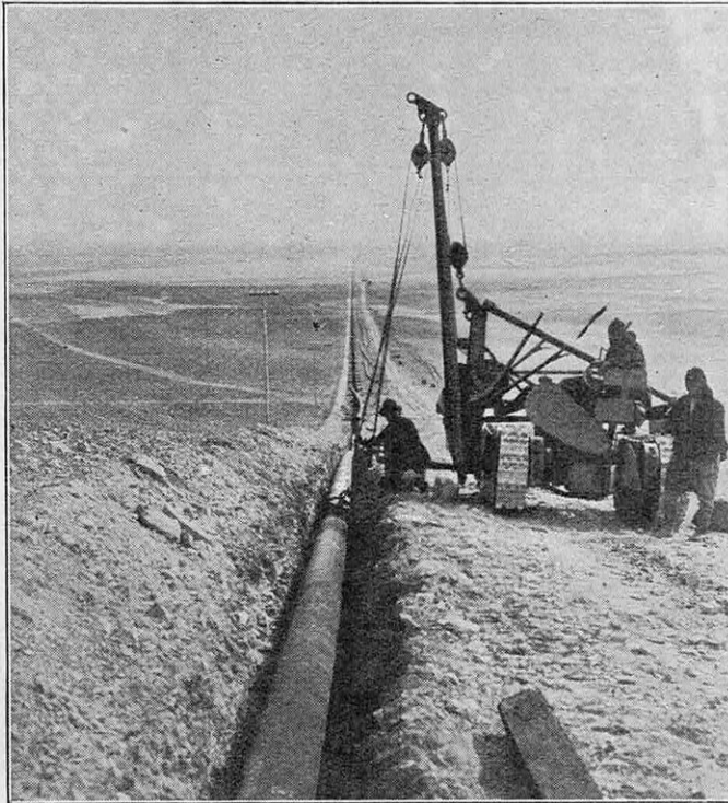
FIG. 4. — L'OPÉRATION DE RACCORDEMENT DES TUYAUX DANS LE « PIPE-LINE » EN CONSTRUCTION
