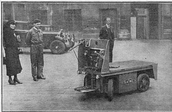
FIG. 2. — VOICI UN VÉHICULE ÉVOLUANT « SANS PILOTE », SUIVANT UN PROGRAMME TRACÉ A L'AVANCE ET ENREGISTRÉ GRACE A L'« ENDOMÉCANIQUE »
