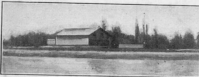
FIG. 3. - QUI PENSERAIT QUE CETTE INNOCENTE REMISE CACHE UN POSTE DE COMBAT POUR MITRAILLEUSES ?
