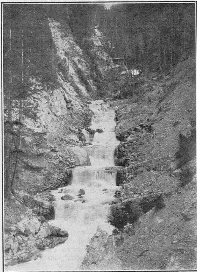
FIG. 6.— COMMENT ON RÉGULARISE LE COURS DE CERTAINS TORRENTS A L'AIDE D'UNE SUCCESSION DE BARRAGES (VOIR « LA SCIENCE ET LA VIE », N° 158, PAGE 104)
