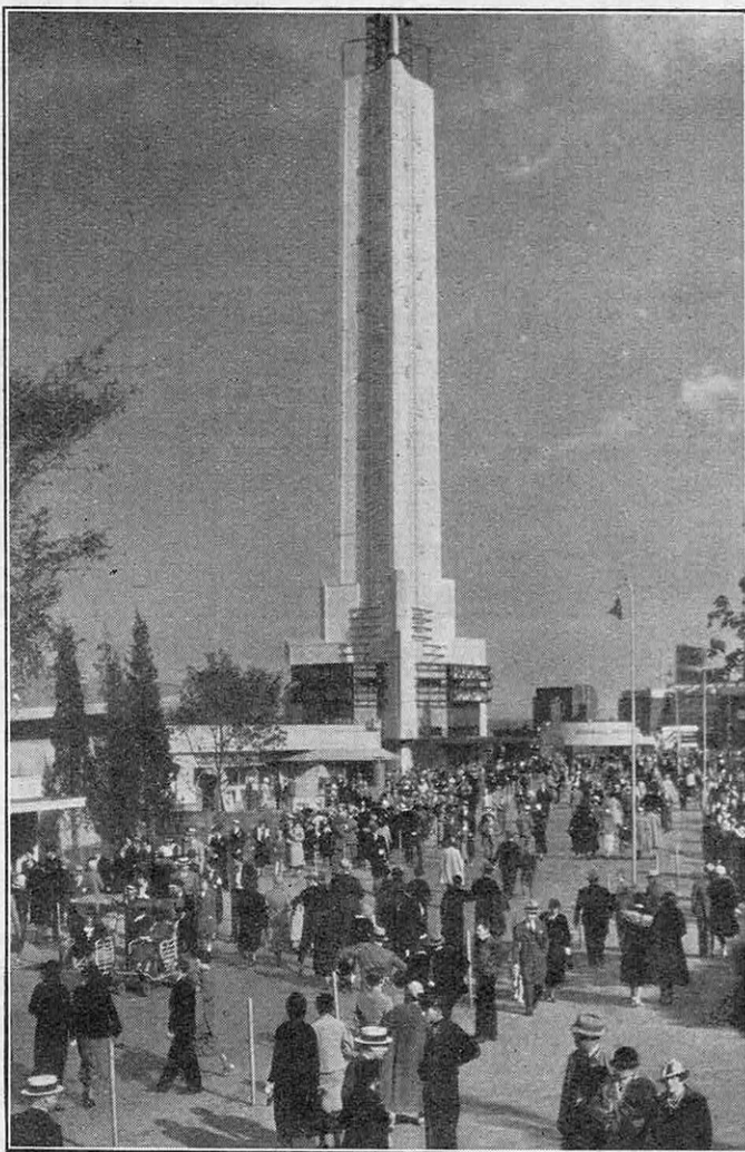
FIG. 3. — UN THERMOMÈTRE DE 60 MÈTRES DE HAUT Dans ce thermo mètre, une des attractions de l'Exposition, les degrés étaient indiqués par des tubes au néon, eux-mêmes commandés par un thermomètre à mercure placé à la base du bâtiment.
