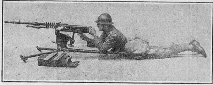
FIG. 4. — LA MITRAILLEUSE FRANÇAISE « HOTCHKISS » Cette mitrailleuse à refroidissement par air est représentée montée sur un affût trépied en position couchée.
