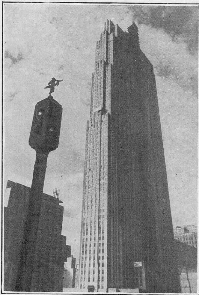
FIG. 5. — LE BATIMENT CENTRAL DE 70 ÉTAGES DU « CENTRE ROCKFELLER » EST TERMINÉ
