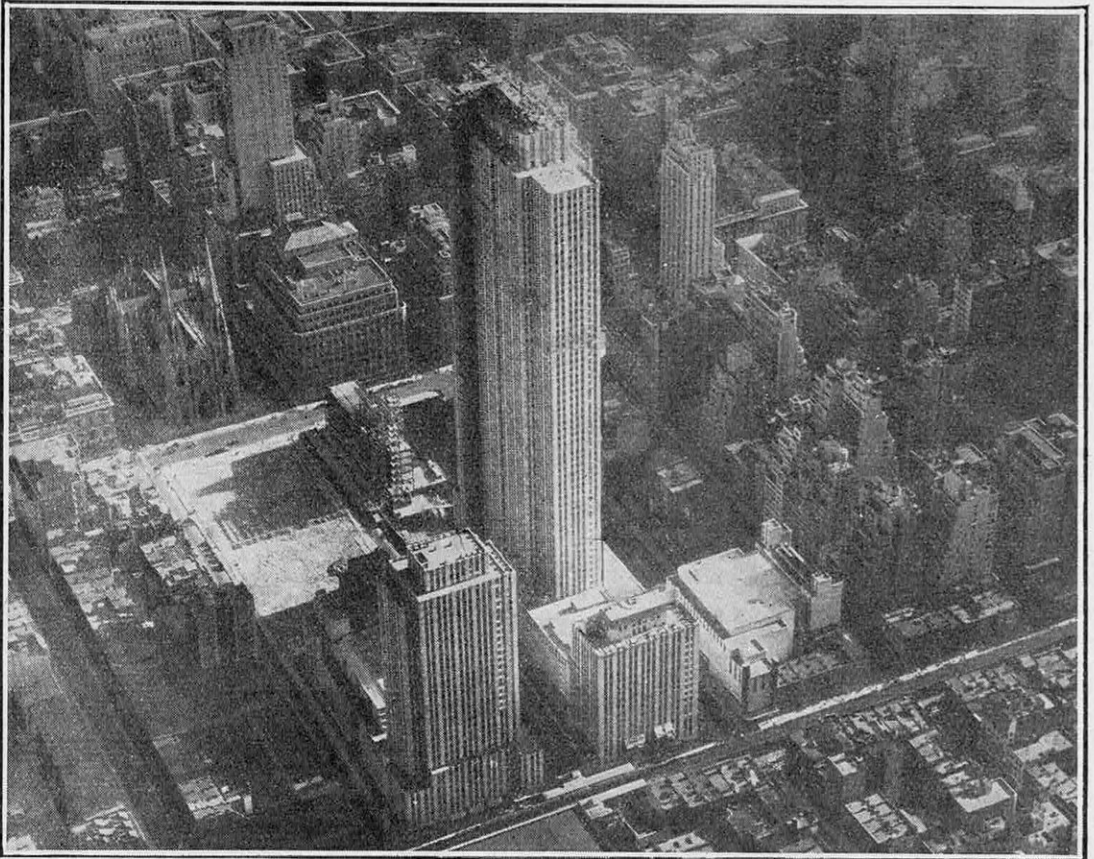
FIG. 6. — VUE D'ENSEMBLE DES TROIS BLOCS QUI CONSTITUERONT LE « CENTRE ROCKFELLER » — COURAMMENT APPELÉ « RADIO-CITY » — EN COURS DE CONSTRUCTION. L'immeuble du centre est presque terminé. Derrière lui, un peu sur la gauche, la Maison Britannique en cours de construction, à côté de laquelle prendra place la Maison de France. Au fond, à gauche, la cathédrale Saint-Patrick semble écrasée par les bâtiments qui l'entourent.
