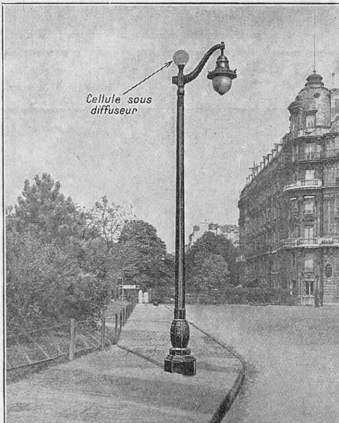
FIG. 1. — LE RÉVERBÈRE DE L'AVENUE FOCH QUI PORTE LA CELLULE PHOTOÉLECTRIQUE
