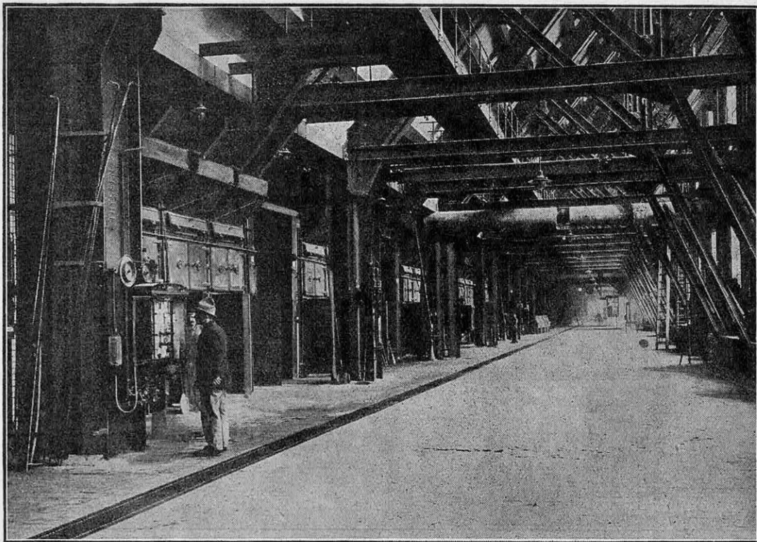
FIG. 6. — VUE INTÉRIEURE DE LA HALLE AUX CHAUDIÈRES (GRILLES EN GRADINS) On remarquera l'absence de tout personnel, le fonctionnement étant entièrement automatique.
