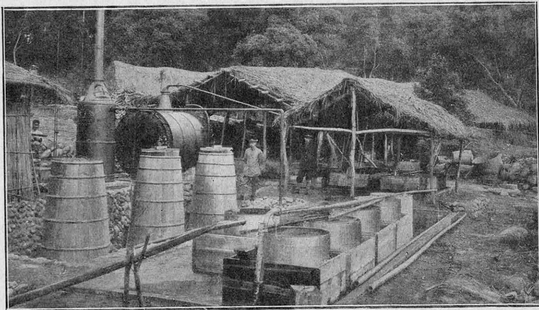
INSTALLATION MODERNE POUR L'OBTENTION DU CAMPBRE PAR DISTILLATION DE COPEAUX DE CAMPRIER DANS LES FORÊTS DE L'ILE DE FORMOSE
