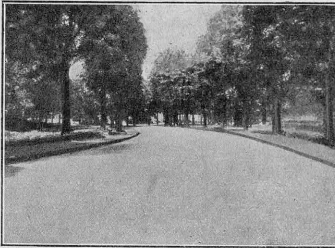
ROUTE EN BÉTON, CONSTRUITE ENTRE LA BELLE-ÉPINE ET CHOISY-LE-ROI (SEINE), SUR LA ROUTE NATIONALE DE VERSAILLES A CHOISY-LE-ROI.
