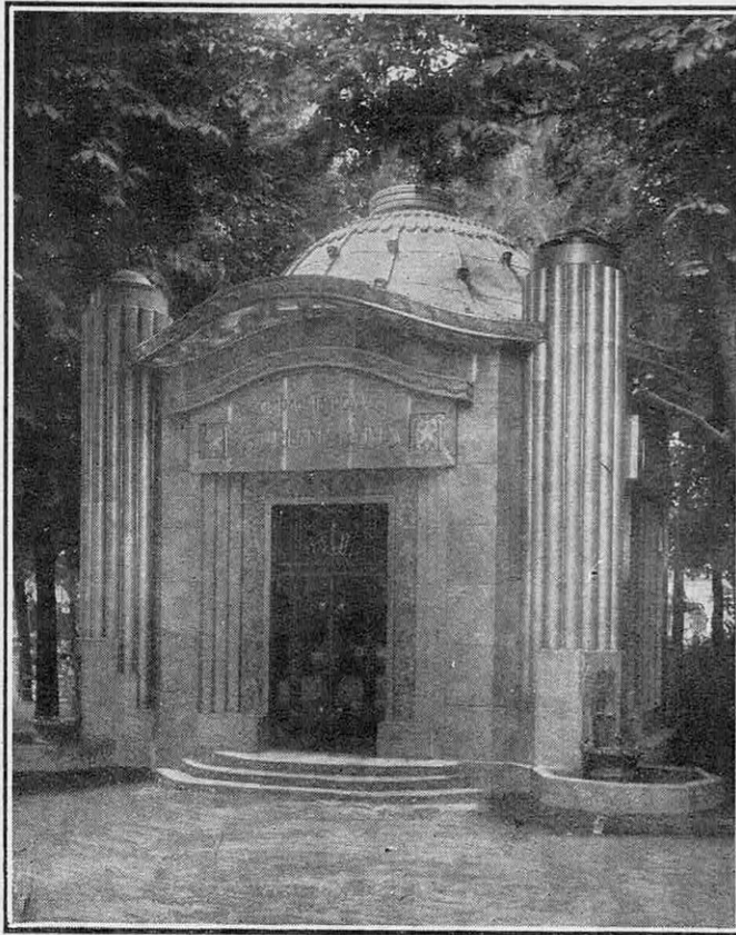
VUE EXTÉRIEURE DU PAVILLON CONSTRUIT, A L'EXPOSITION DES ARTS DÉCORATIFS, PAR M. GUILLAUME TRONCHET, ARCHITECTE EN CHEF DU GOUVERNEMENT, POUR LA COMPAGNIE ROYALE ASTURIENNE DES MINES
