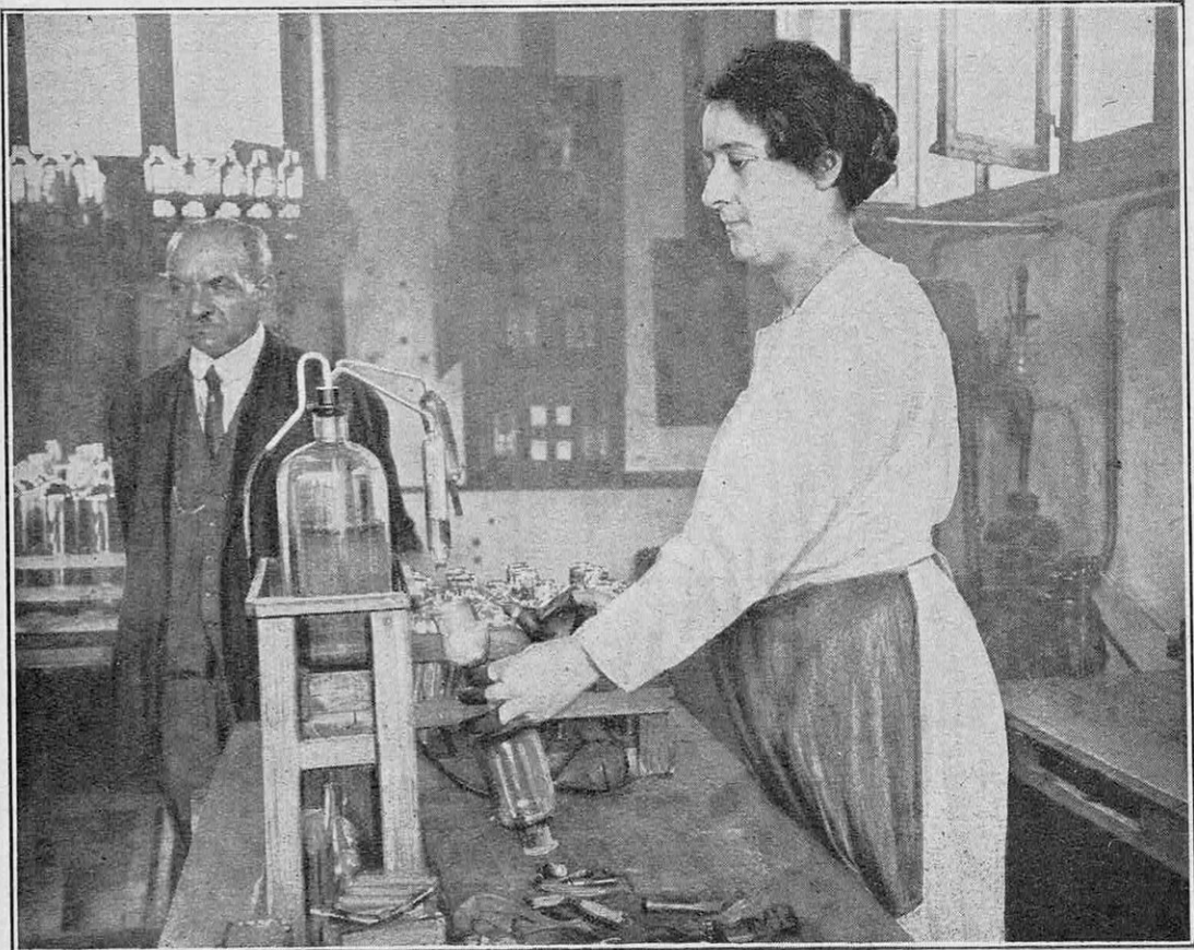
FIG. 5. — REMPLISSAGE DE LA DOUBLE PAROI POUR L'ARGENTURE
