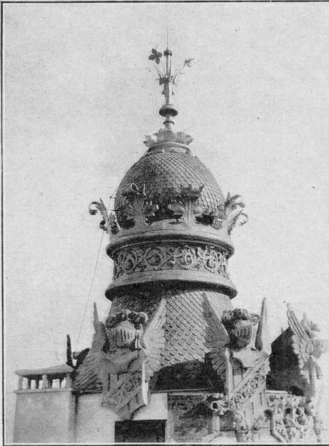
UN EXEMPLE PARTICULIÈREMENT RÉUSSI DE DÉCORATION PAR LE ZINC, SUR UNE MAISON PARTICULIÈRE EN ESPAGNE
