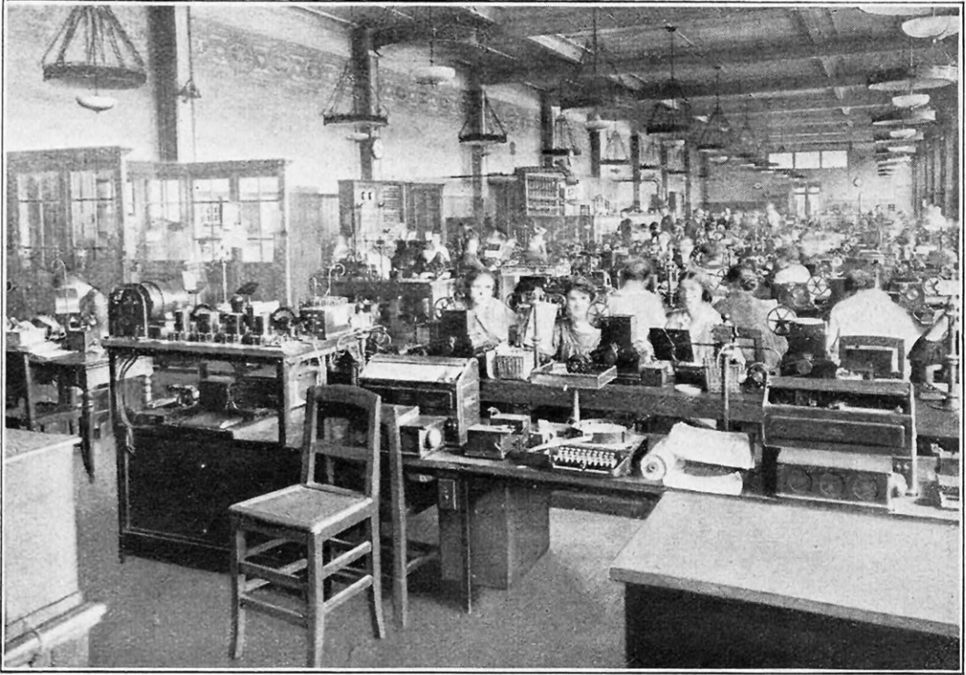
FIG. 4. — VUE GÉNÉRALE DE L'UNE DES QUATRE SALLES CONSTITUANT LE CENTRAL TÉLÉGRAPHIQUE DE PARIS. — C'EST LA SALLE C, LA PLUS RÉCEMMENT CONSTRUITE
