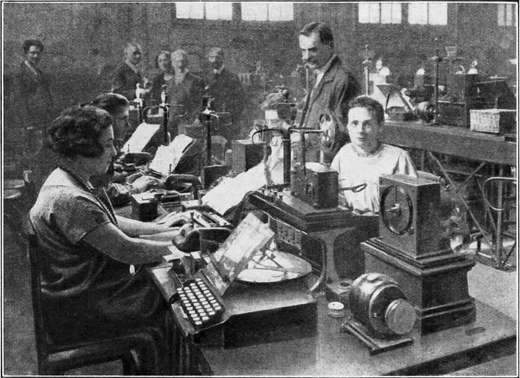
FIG. 10. — L'INSTALLATION DE « MARSEILLE » AU POSTE CENTRAL DE PARIS
