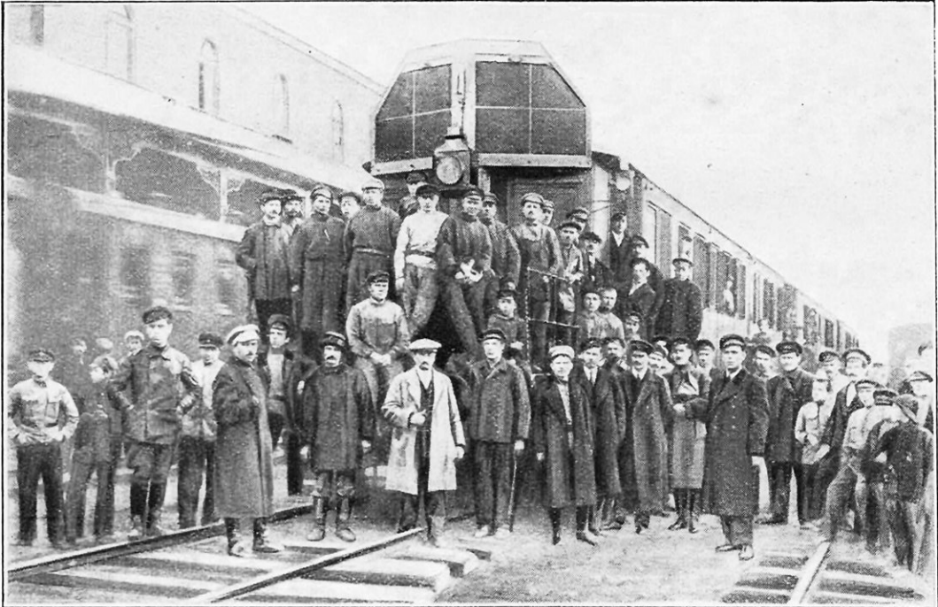
LE TRAIN ÉLECTRIQUE DE M. MAKHONINE A LA GARE NIKOLAIEVSK, A PÉTROGRAD
