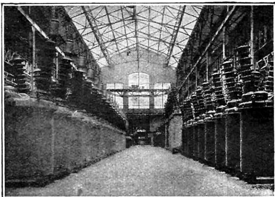
USINES DE VILLEURBANNE (Rhône) - HALL DE MONTAGE
