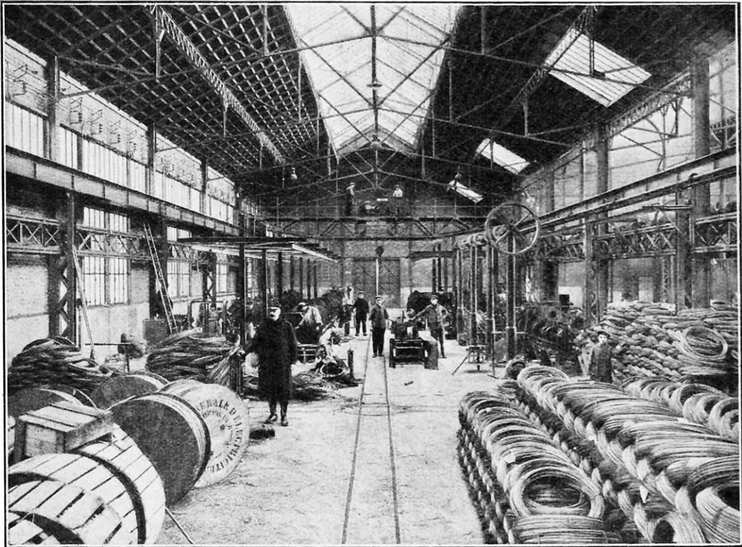
LES FILS D'ALUMINIUM SONT TORONNÉS ET CABLÉS, AVEC UNE ÂME D'ACIER, PAR DES MACHINES SPÉCIALES
