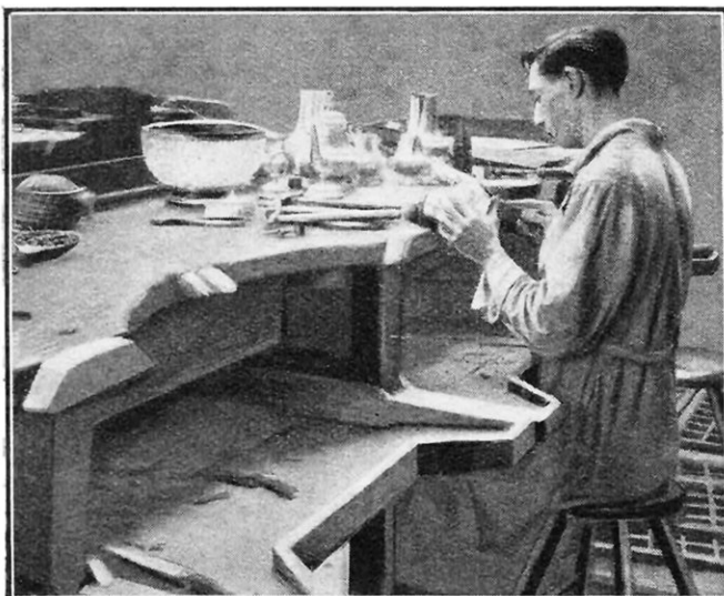
PLATEAUX RECUEILLANT LES LIMAILLES ET PARTICULES Dans les ateliers d'orfèvrerie argent, l'ouvrier travaille à l'aplomb d'un plateau de bois échancré de manière à entourer le corps, doublé sur le dessus d'une feuille de zinc et percé d'une ouverture débouchant au-dessus d'un tiroir.
