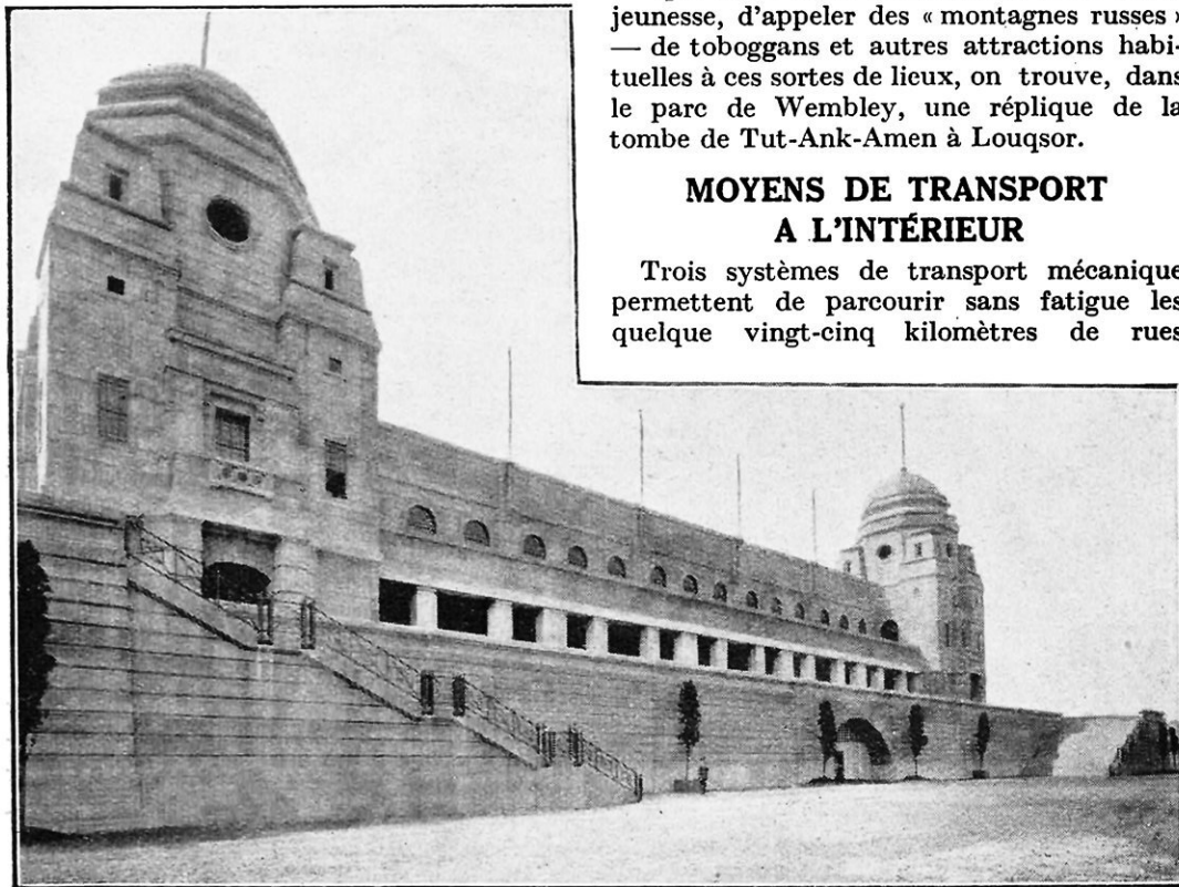
VUE EXTÉRIEURE DU STADE, BATIMENT ENTIÈREMENT CONSTRUIT EN CIMENT ARMÉ
