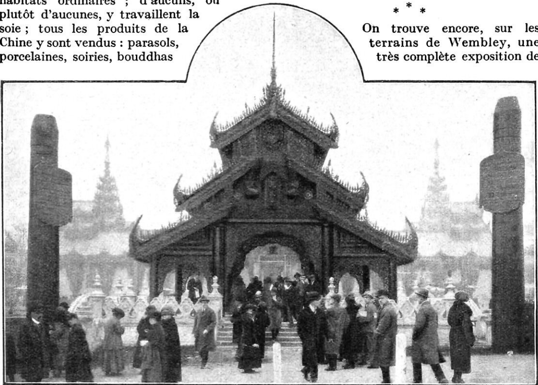
CETTE ENTRÉE PRINCIPALE DU PAVILLON DE LA BIRMANIE EST UNE RÉPLIQUE EXACTE DE L'UNE DES PORTES DE LA FAMEUSE PAGODE ARAKAN, A MANDALAY
