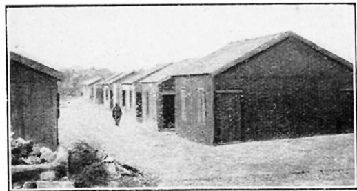
UNE RUE DU VILLAGE OLYMPIQUE
