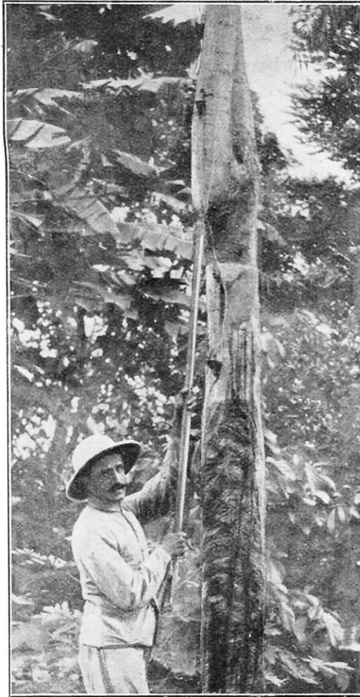
POSE DU VASE EN FORME D'ENTONNOIR DANS LEQUEL COULERA LE LATEX APRÈS INCISION DE L'ARBRE (MADAGASCAR)
