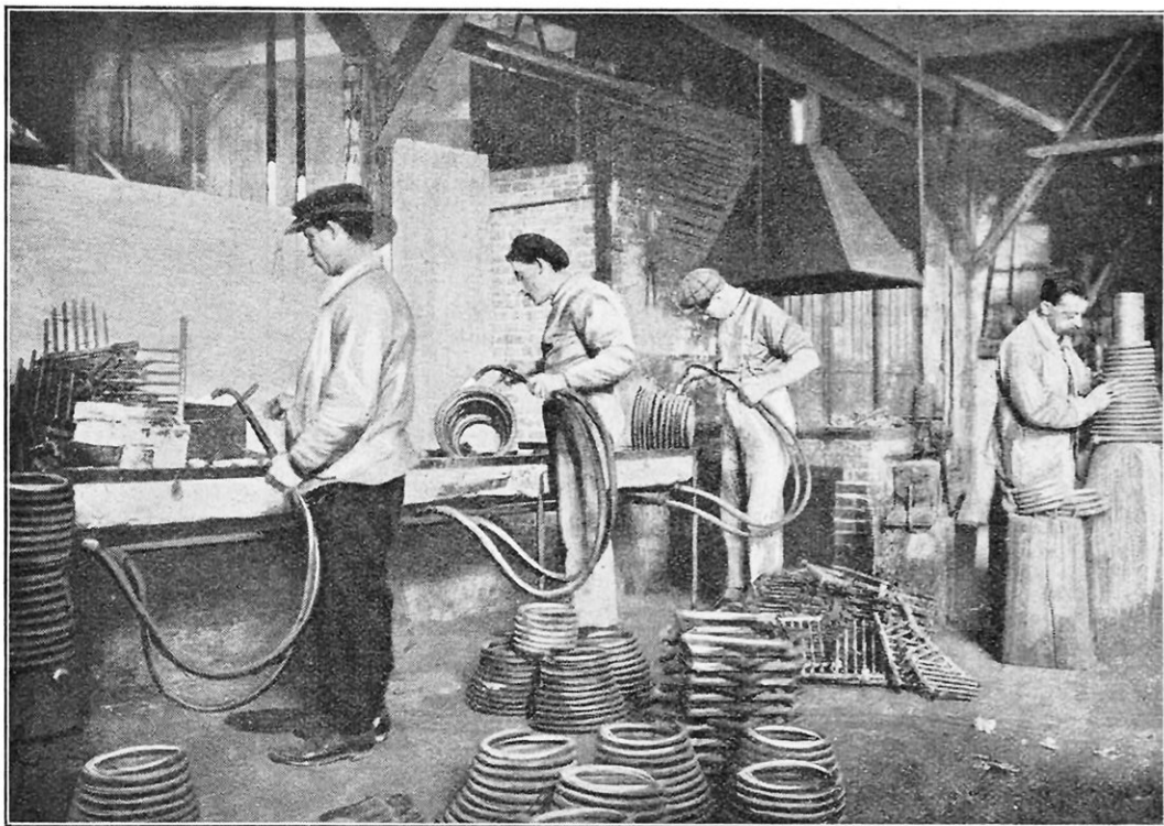
OPÉRATION DU BRASAGE, AU CHALUMEAU, DES DIFFÉRENTS SERPENTINS
