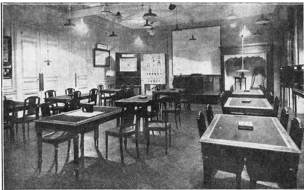
FIG. 8. — AVEC DES RÉFLECTEURS CONIQUES, LES RÉSULTATS SONT DÉJÀ MEILLEURS
