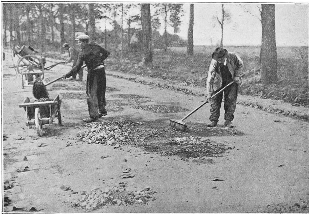
FIG. 3. — CONFECTION DE L' « EMPLOI » (REMBLAYAGE DES FLACHES OU « NIDS DE POÛLES ») Dans les excavations préparées par la piocheuse, on place des matériaux neufs de dimensions et de nature aussi semblables que possible à ceux de l'empierrement primitif.
