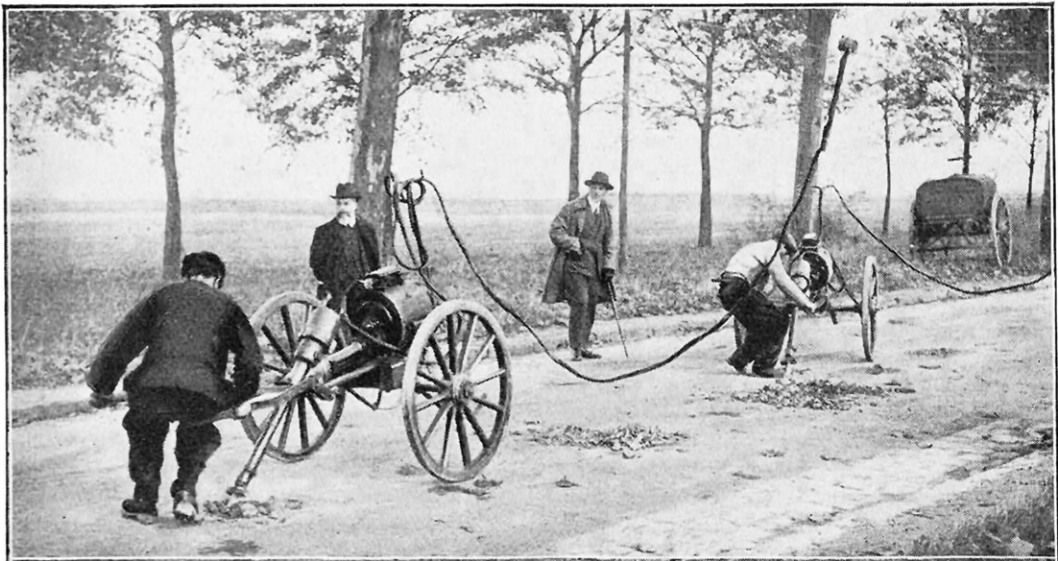
FIG. 1. — RÉFECTION ÉLECTRO-MÉCANIQUE DES ROUTES PAR LES PROCÉDÉS MAURICE COLLET Les « flaches » de la route, délimitées à la craie par le chef cantonnier, sont attaquées par des piocheuses électro-mécaniques fonctionnant à grande vitesse et sans projection ni bris de matériaux.
