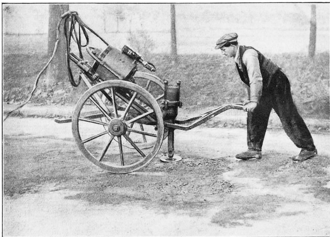
FIG. 4. — PILLONNEUSE ÉLECTRO-MÉCANIQUE COLLET AU TRAVAIL
