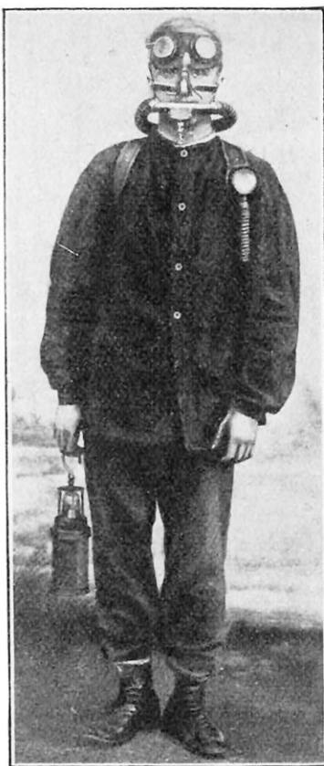
FIG. 1. — SAUVETEUR MUNI DE L'APPAREIL RESPIRATOIRE, SYSTÈME FENZI
