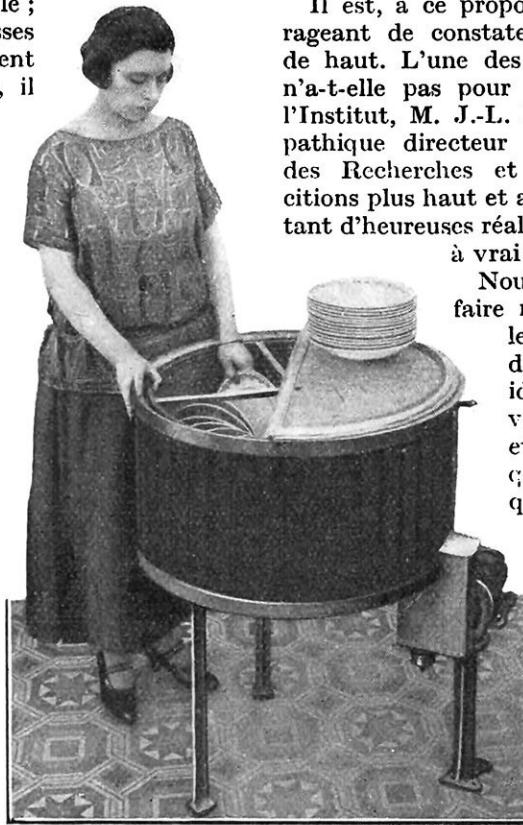
FIG. 1. — PETIT MODÈLE DE LA MACHINE A LAVER LA VAISSELLE, A PANIER TOURNANT ET POMPE CENTRIFUGE, IMAGINÉE ET MISE AU POINT PAR M. J.-L. BRETON, DE L'INSTITUT
