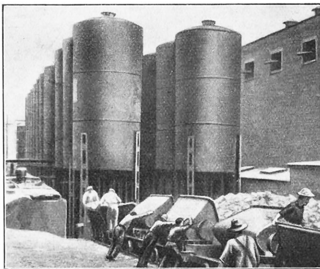
FIG. 7. — BATTERIE DE FILTRES POUR HUILES DE GRAISSAGE DE HAUTE QUALITÉ
