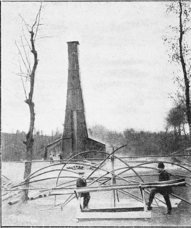
FIG. 5. — DÉCOUVERTE ET CAPTAGE D'UN GEYSER D'EAU MINÉRALISÉE (NOVEMBRE 1919) C'est le jaillissement d'eau des Martres-d'Artières, dans le Puy-de-Dôme.
