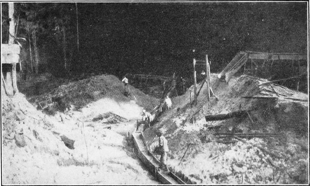
UN SLUICE EN PLEINE ACTIVITÉ AU PLACER AWA (GUYANE HOLLANDAISE)
