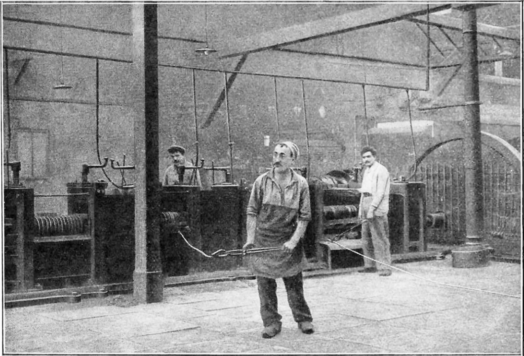
MACHINES SPÉCIALES POUR LE LAMINAGE ULTRA-RAPIDE DES FILS DE MAGNÉSIUM
