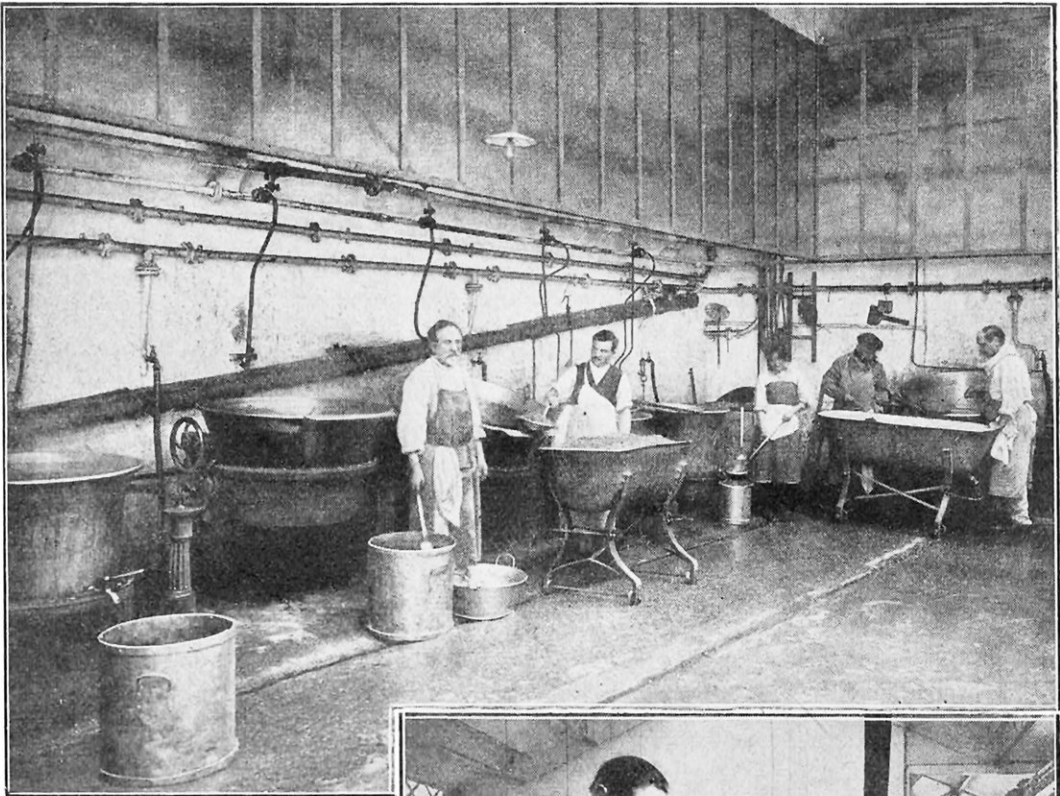
FIG. 5. — BASSINES BASCULANTES CHAUFFÉES A LA VAPEUR ET SERVANT A BLANCHIR LES PETITS POIS
