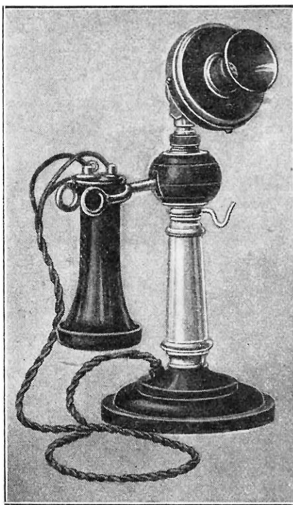
FIG. 15. — POSTE MOBILE DU « MATÉRIEL TÉLÉPHONIQUE » ÉQUIPÉ AVEC UN MICROPHONE « SOLID-BACK » ET UN RÉCEPTEUR TYPE BELL.
