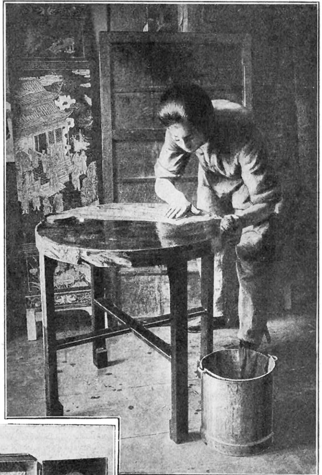
FIG. 11. — POLISSAGE D'UNE TABLE DE LAQUE ROUGE, IMITATION DE LAQUE DE PÉKIN
