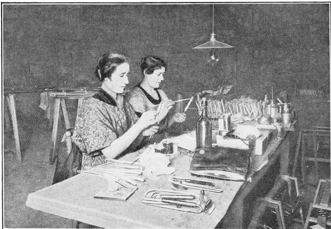
FIG. 2. — ATELIER DE PRÉPARATION DES PETITS TUBES LUMINESCENTS
