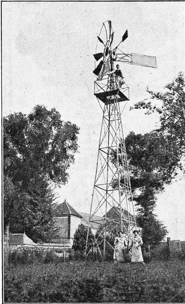
ESSAI D'UNE ÉOLIENNE DESTINÉE AUX COLONIES Ce modèle d'éolienne a été spécialement étudié pour son emploi aux colonies où il doit être utilisé à la production du courant électrique.
