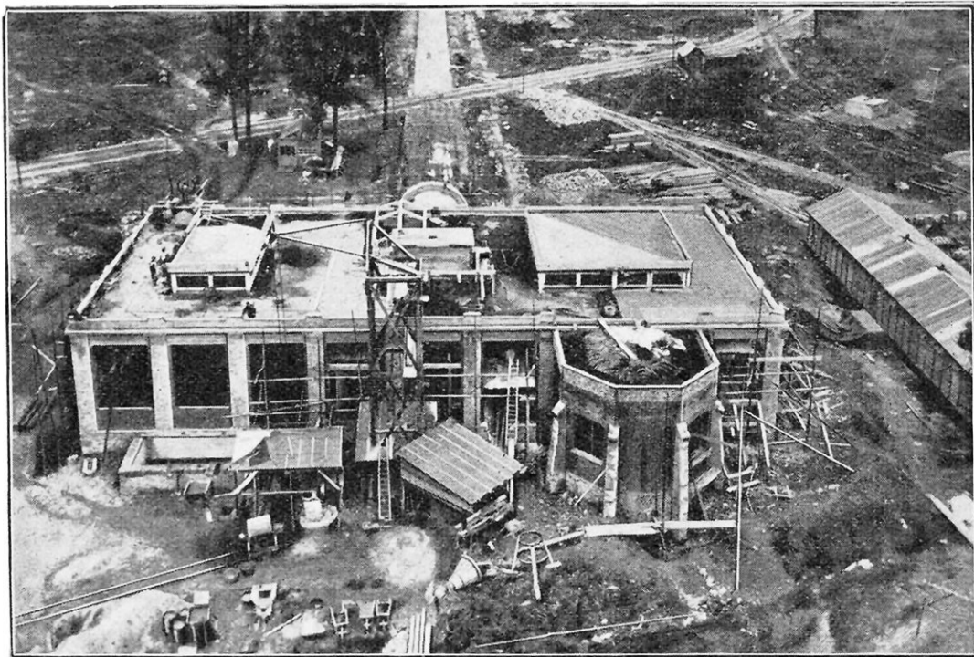
BÂTIMENT, EN COURS DE CONSTRUCTION, DE LA « STATION CONTINENTALE »
