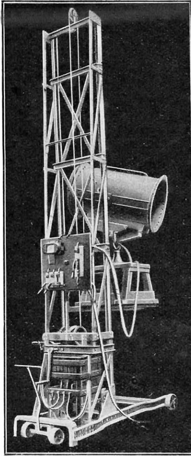
FIG. 8. — LE PROJECTEUR SAUTTER HARLÉ MONTÉ SUR SON PIED MÉTALLIQUE
