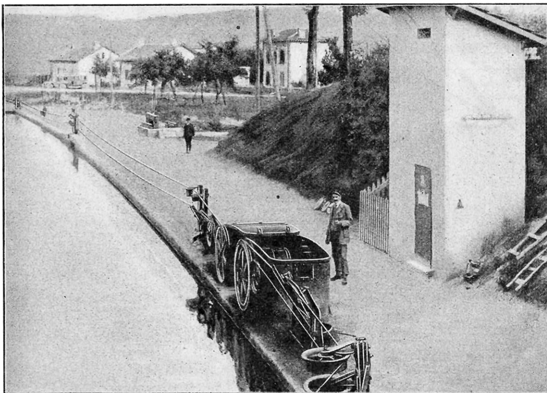
HALAGE FUNICULAIRE AUX ABORDS DU SOUTERRAIN DE FOUG (MEURTHE-ET-MOSELLE)
