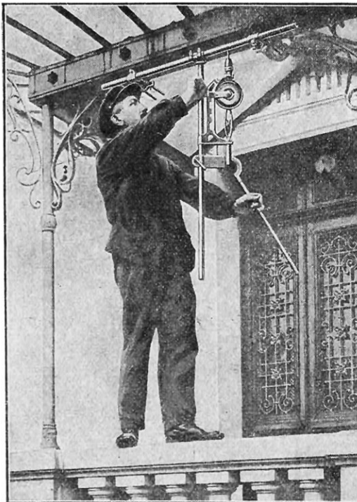
L'OUVRIER PERCE UN TROU DANS UNE PIÈCE MÉTALLIQUE PLACÉE AU-DESSUS DE SA TÊTE. L'axe de l'appareil est maintenu fixe grâce à l'emploi de la barre horizontale sur laquelle on assujettit le tube sur lequel est monté la perceuse.
