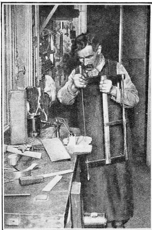
CHANTOURNAGE DE LA TABLE D'HARMONIE Sur la planchette, quelquefois composée de deux morceaux juxtaposés, l'ouvrier a dessiné les contours qu'il découpe soigneusement à la scie.
