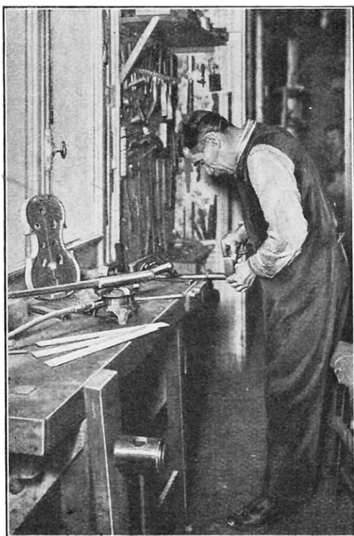
LE MONTAGE DES ÉCLISSES SUR LE MOULE On les serre sur le moule à l'aide de happes dont une extrémité prend appui dans un des huit trous ménagés, à cet effet, dans ledit moule. (Voir la figure du bas de la page précédente.)
