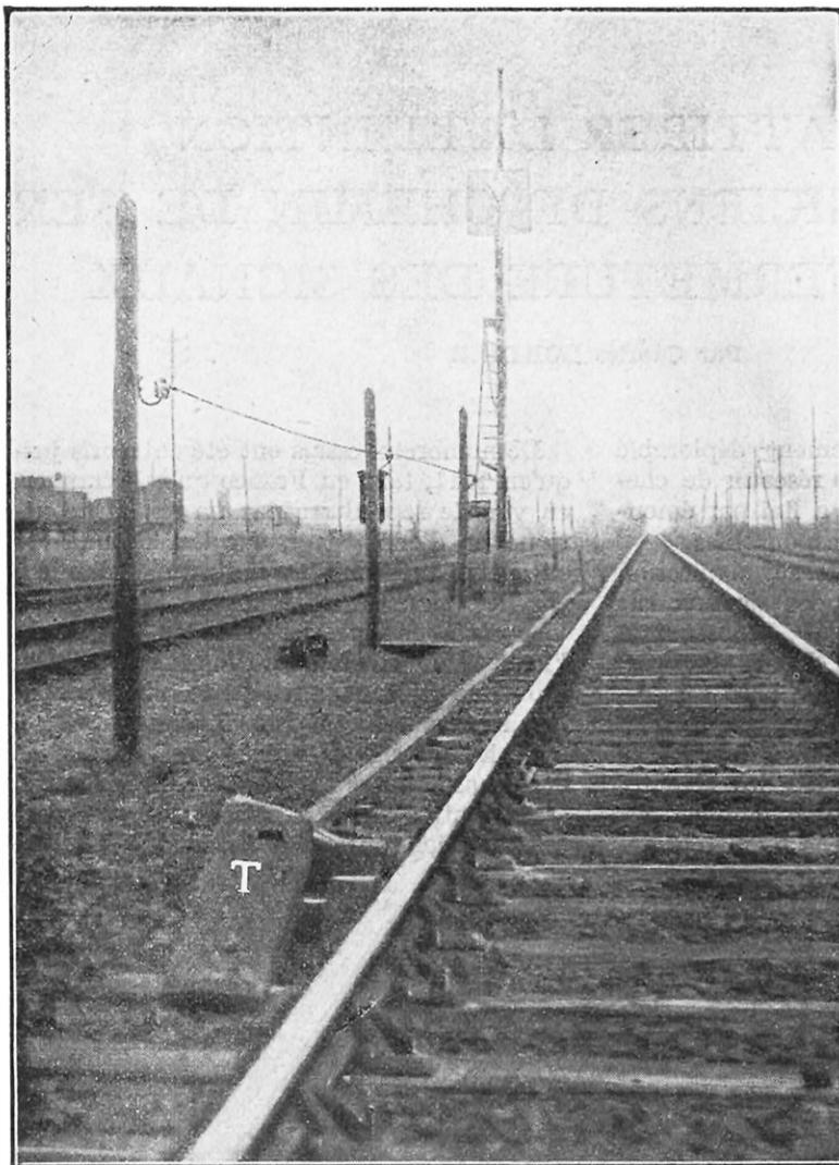
FIG. 3. — VUE PERSPECTIVE DES APPAREILS FIXES DU SYSTÈME RÉPÉTITEUR DE SIGNAUX AUGEREAU
