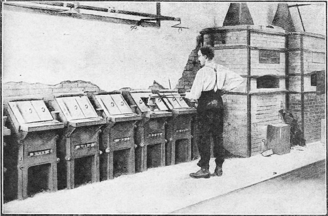
BATTERIE DE FOURS D'ESSAI DES MINERAIS D'OR A L'USINE DE LA BELLIÈRE
