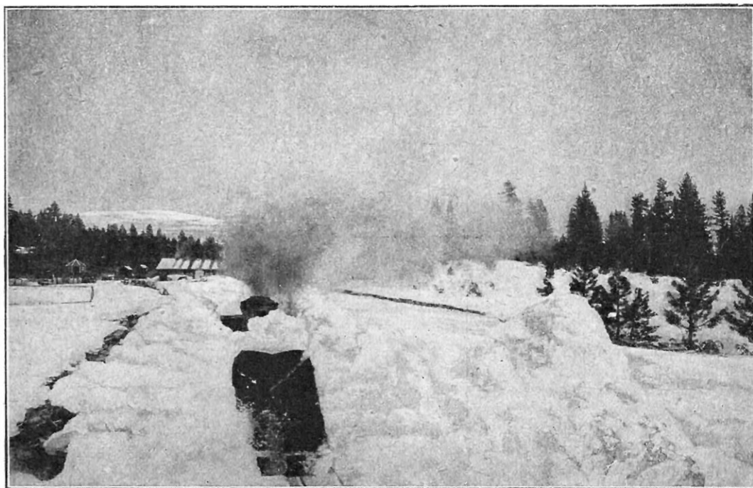
LOCOMOTIVE CHASSE-NEIGE DÉBLAYANT LES VOIES DU « SOUTHERN PACIFIC RAILROAD », DANS LE VOISINAGE DE HOBART MILLS (CALIFORNIE)
