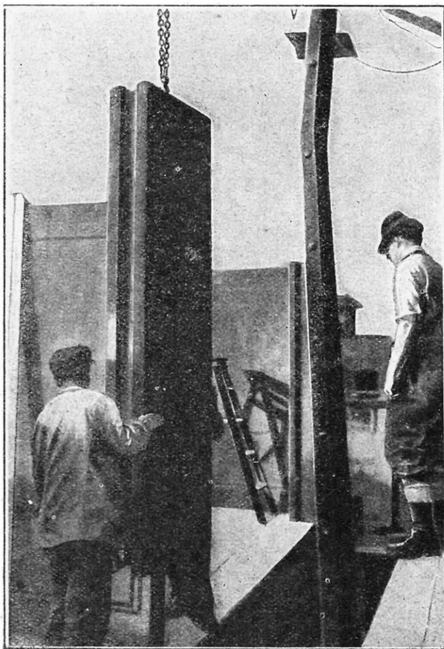
FABRICATION DES PANNEAUX DE MURAILLES
