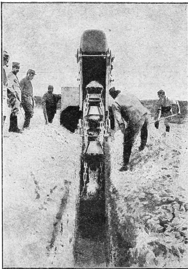
UN EXCAVATEUR AU TRAVAIL SUR LE FRONT
