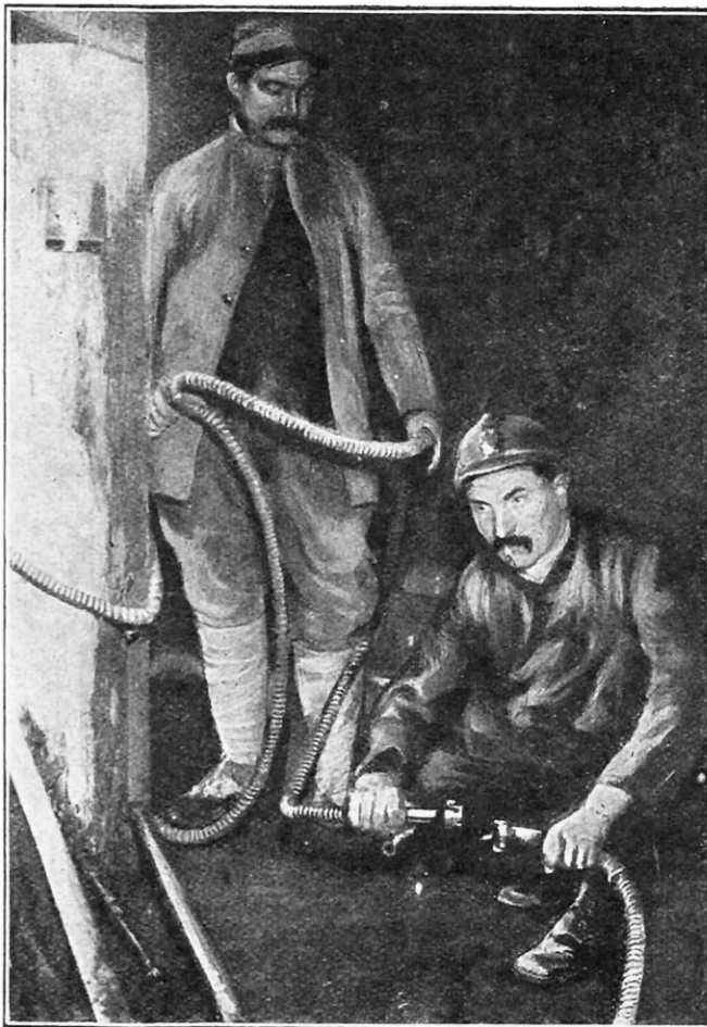
SAPEUR DU GÉNIE RACCORDANT LE TUYAU D'ALIMENTATION D'UN MARTEAU-PIQUEUR A LA CONDUITE GÉNÉRALE D'AIR COMPRIMÉ VENANT DE LA STATION DE POMPAGE, SOUVENT ÉLOIGNÉE
