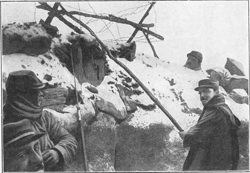
CHEVAL-DE-FRISE FAIT DE BRANCHAGES ET GARNI DE RONCES ARTIFICIELLES
