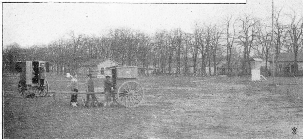
MAT SUPPORT D'ANTENNE DÉMONTABLE D'UN POSTE DE CAMPAGNE
