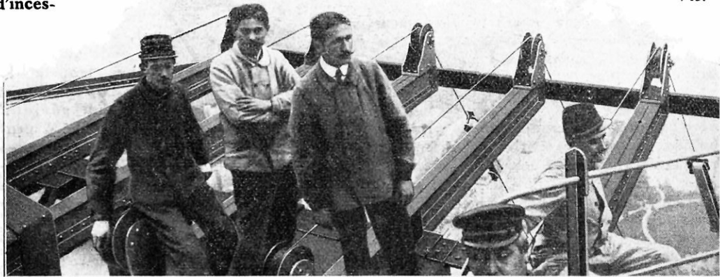
ACCROCHAGE DES FILS D'ANTENNE AU SOMMET DE LA TOUR EIFFEL.
